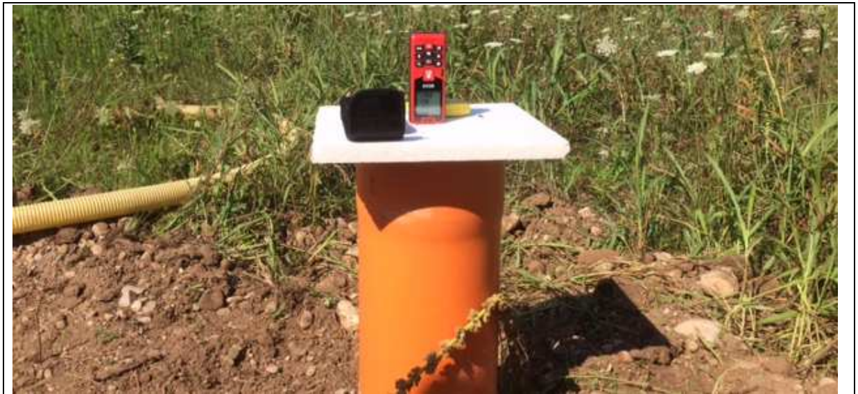
Figura 17 - Predisposizione del pozzetto di prova
