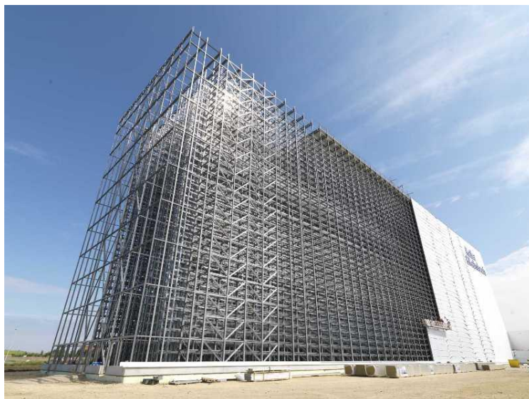
Immagine di un magazzino automatico in fase di realizzazione
