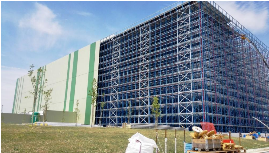
Immagine di un magazzino automatico in fase di realizzazione
