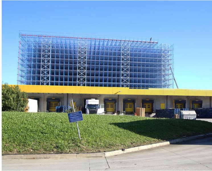
Immagine di un magazzino automatico in fase di realizzazione
