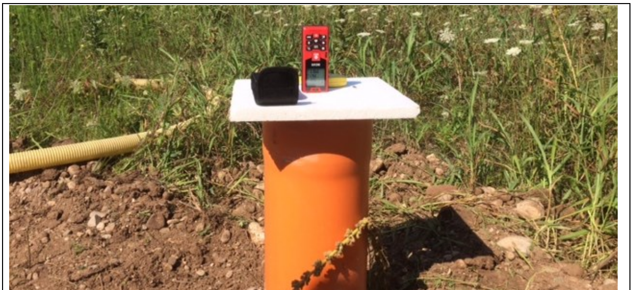
Figura 17 - Predisposizione del pozzetto di prova
